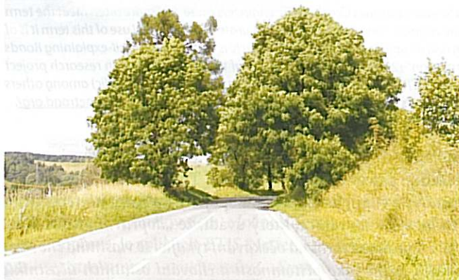
Obr. 3 Řidič je nedostatečně informován o úseku před sebou - nevyznačený směrový oblouk, změna šířky a povrchu vozovky
